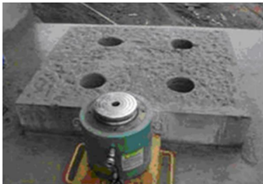
图9 垫石凿毛示意图
